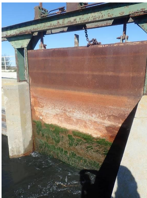
Vanne contrôlant le canal du Versadou au niveau du pertuis de la Comtesse
