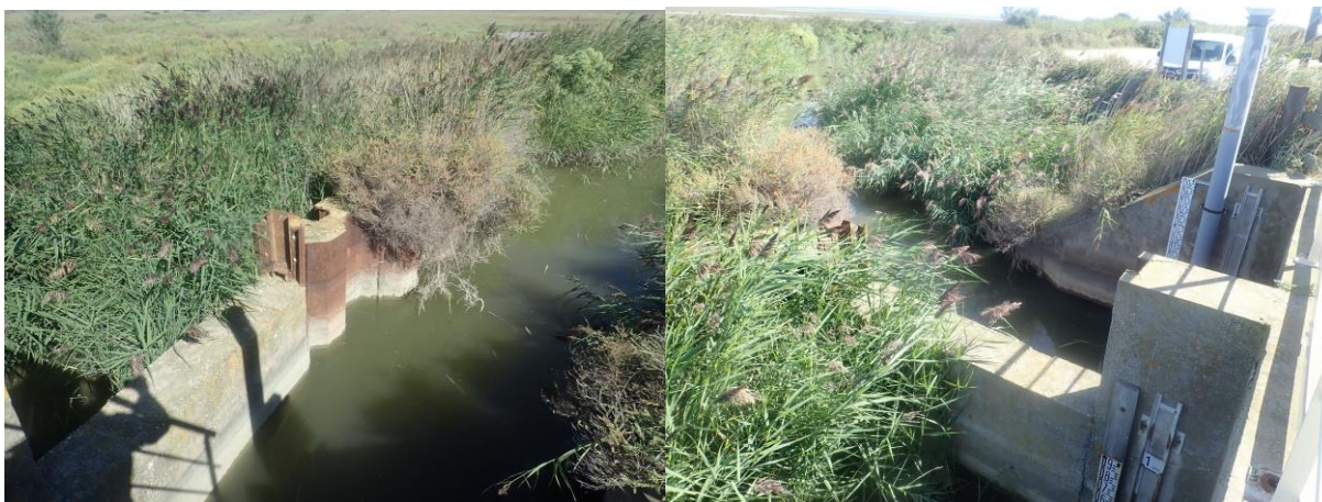
Palplanches existantes quelques mètres en amont (ouest) à l'exutoire du Versadou
